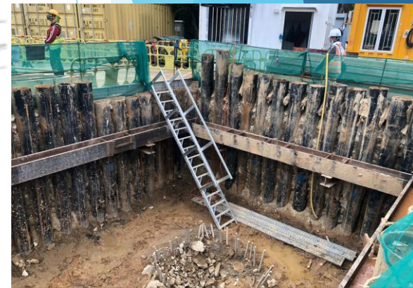
D1-03 ELS wailing welding in Progress
