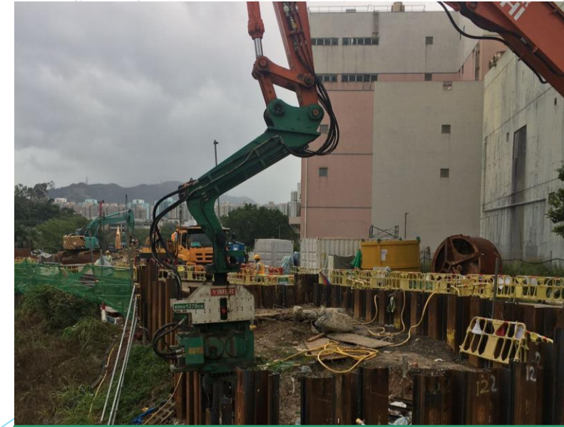
C1-02b ELS Sheet Piling Works in Progress
