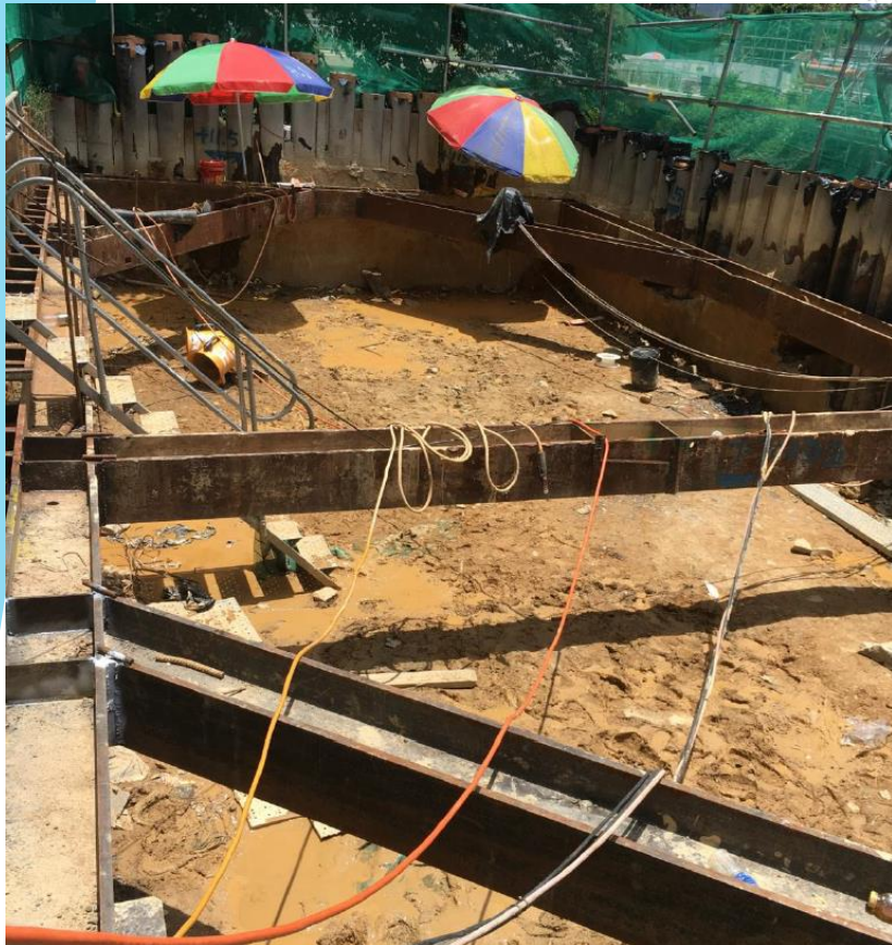
C1-01b 1 st layer of ELS waling and struts Completed
