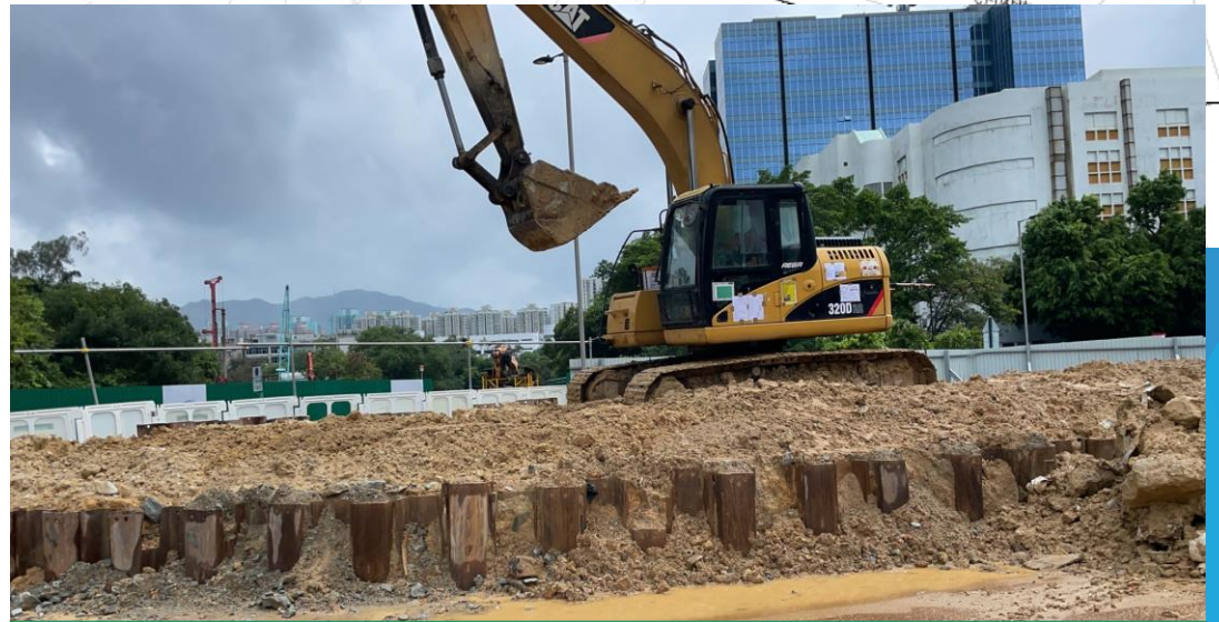
ELS excavation work in progress in C1-04
