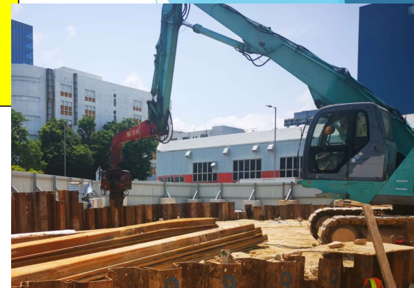
ELS Sheet Pile works completed in C1-04
