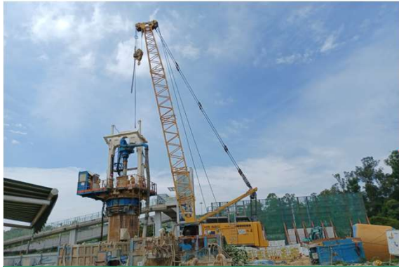
E2-01-P1: RCD Drilling
