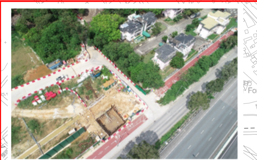
Portion 1 (LP, ELS and Pipe Jacking)
