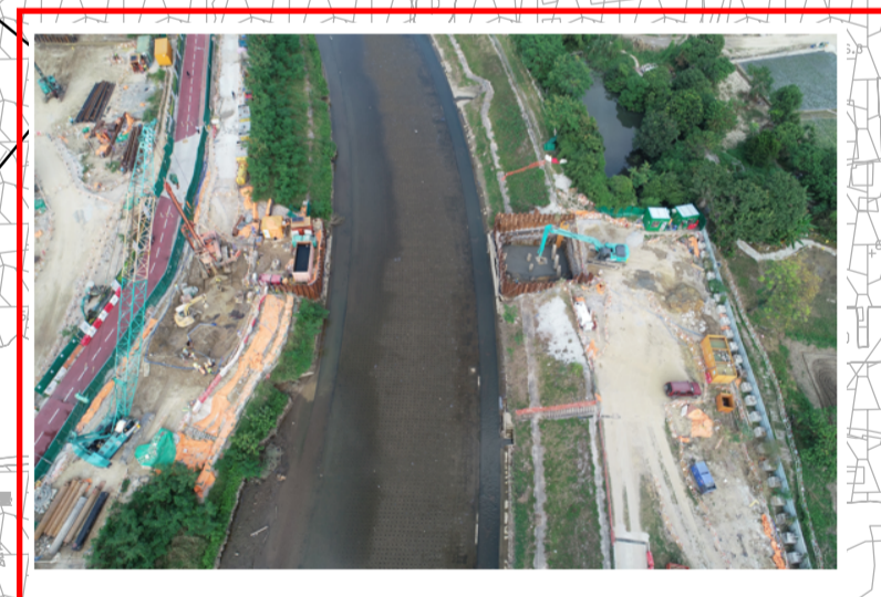
Footbridge (Portion 9N, Pile cap)
