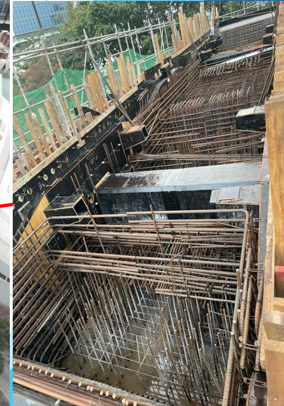
Rebar fixing for 2 nd pour in progress
