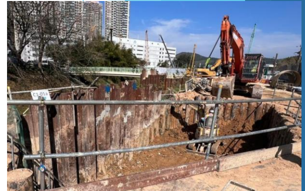
C1-01a ELS 1 st layer Excavation in progress
