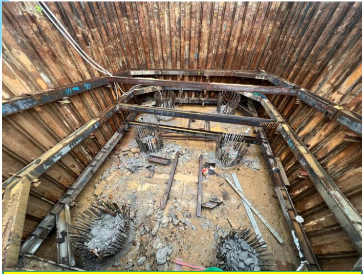
B2-03 3 rd ELS strut layer strut installation completed
